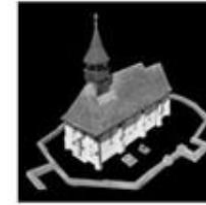
CSONGRÁD-CSANÁD MEGYEI ÉPÍTÉSZ KAMARA
